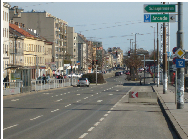
Abbildung 8: Autostraßenähnliche Gestaltung der Eichenstraße.
